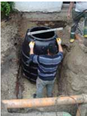
3.) Abscheider ausrichten
