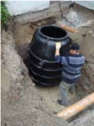
2.) Abscheider einsetzen
