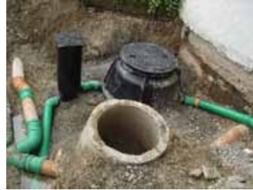
6.) Abwasserrohr wasserdicht anschließen
