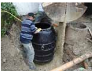
4.) Abscheider schrittweise abwechselnd mit Wasser befüllen (ca. 20 cm) dann Kiesschüttung (ca. 20 cm) herstellen und verdichten usw. Darauf achten, dass der Abscheider in Wasser steht.
