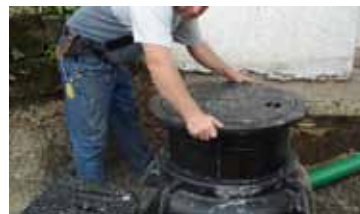
8a.) TOPATEC- Teleskopschachtaufsatz einsetzen
