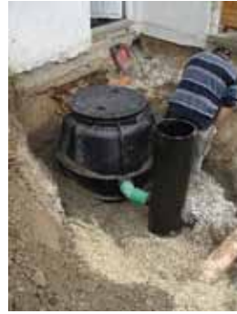
5.) Probenahmeschacht setzen und anschließen
