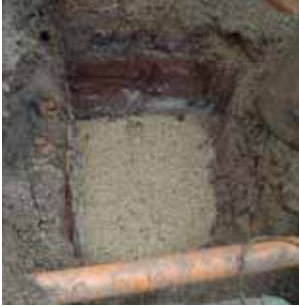
1.) Baugrube vorbereiten und Kies/Sandunterlage herstellen
