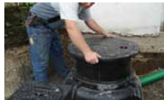
8a.) TOPATEC Teleskopschachtaufsatz einsetzen (bis Klasse B125)
