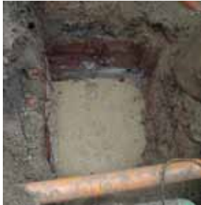
1.) Baugrube vorbereiten und Kies/Sandunterlage herstellen
