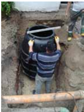
3.) Fettabscheider ausrichten
