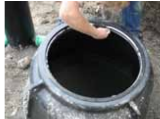
7.) Rahmen säubern, Lippendichtung einsetzen und genügend Gleitmittel aufbringen
